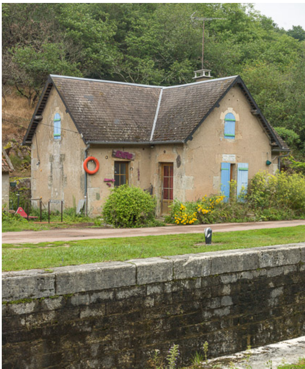
Vue de la maison éclusière.
