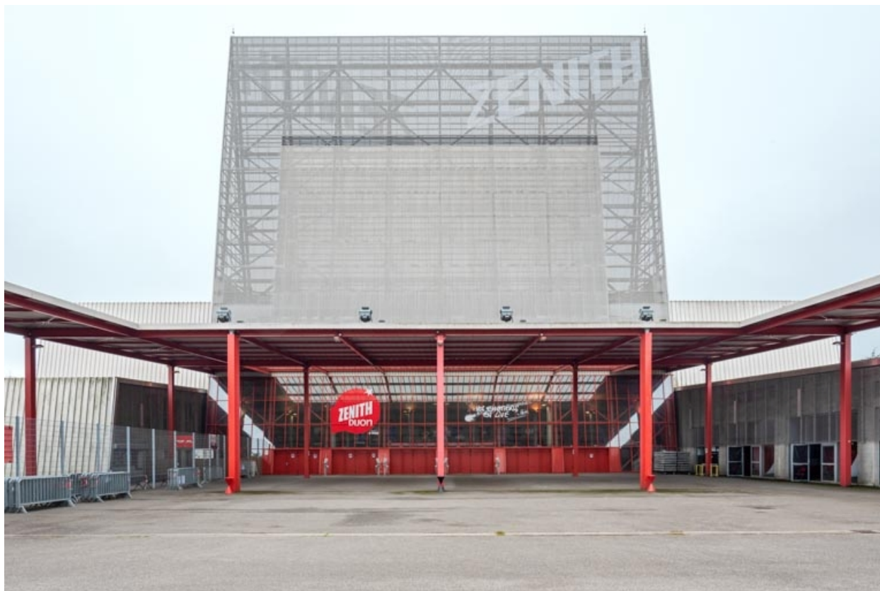
Corps principal, avec portiques et façade-écran.
