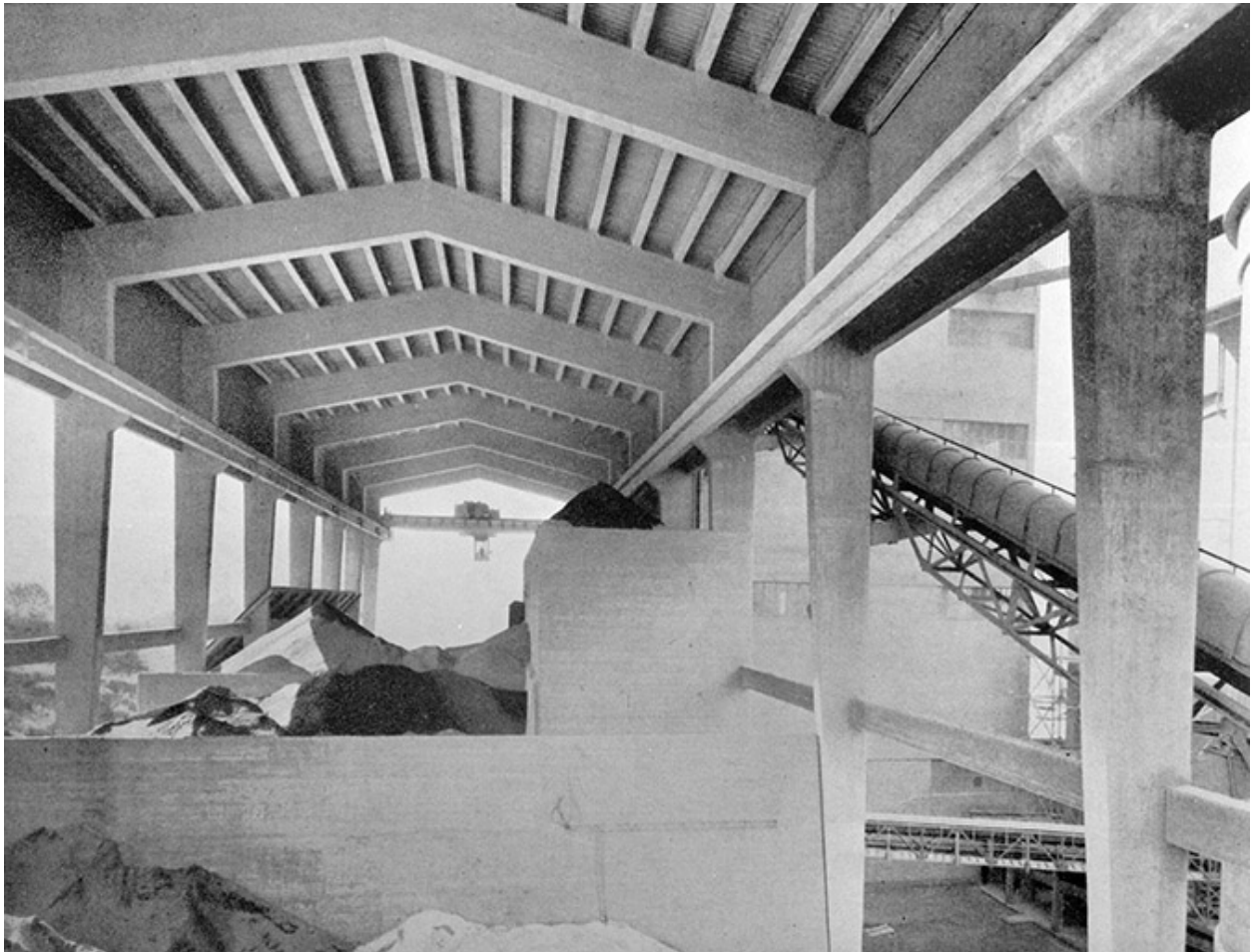
Hall de stockage et de manutention.
