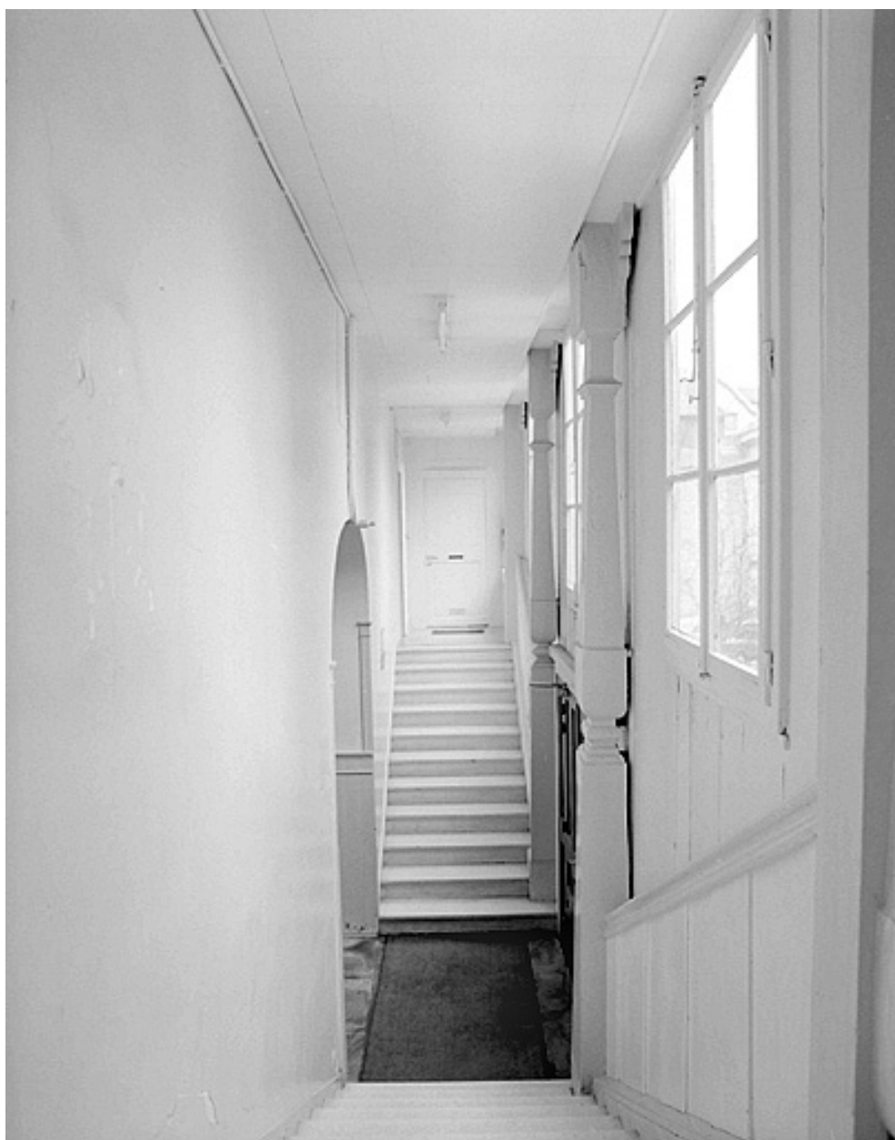
Escalier de la galerie de distribution.
