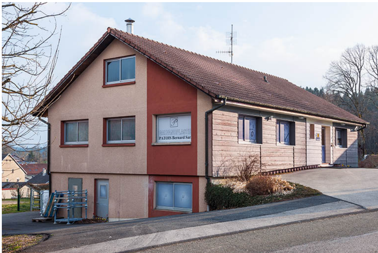
Usine : façade antérieure, de trois quarts gauche.
