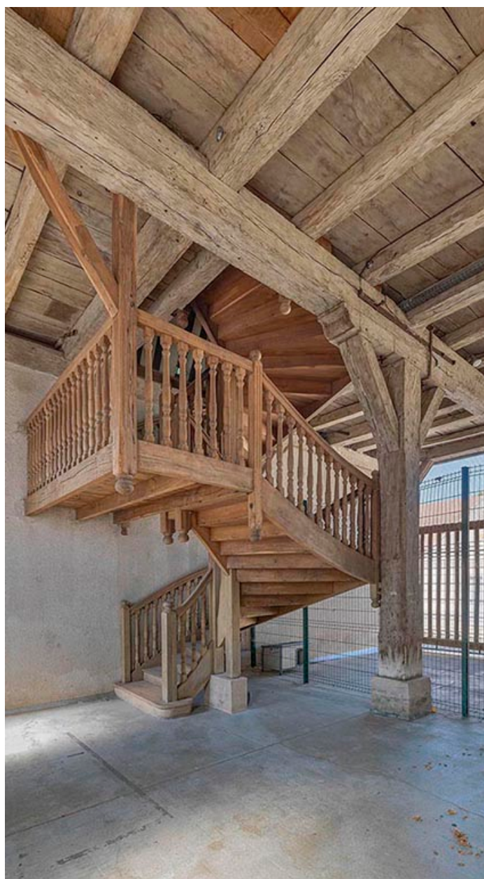
Escalier desservant l'étage supérieur du hangar.
