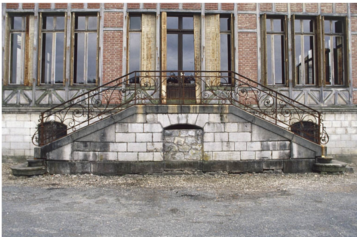
Escalier sur la façade postérieure.
