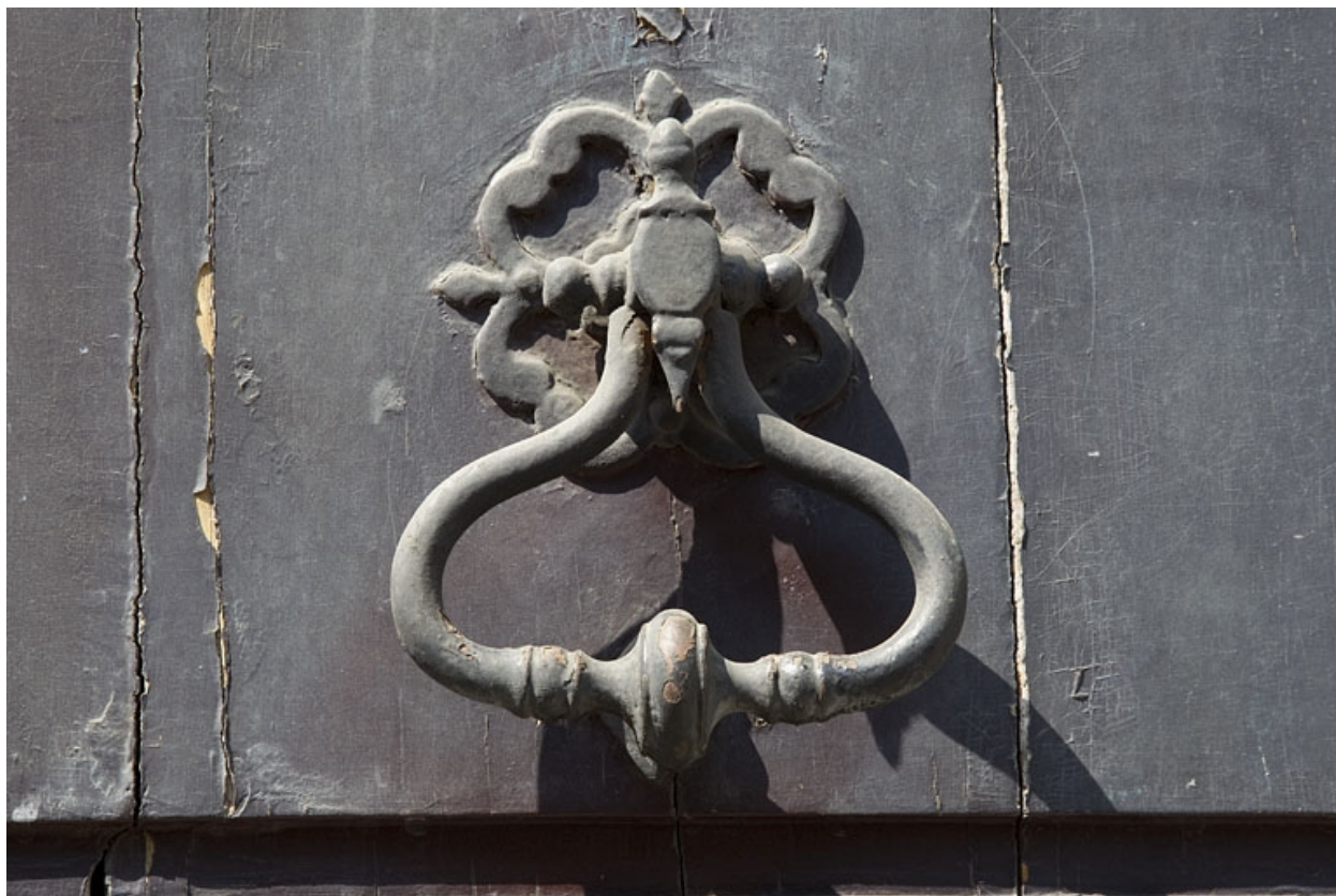
Portail d'entrée : détail du heurtor.
