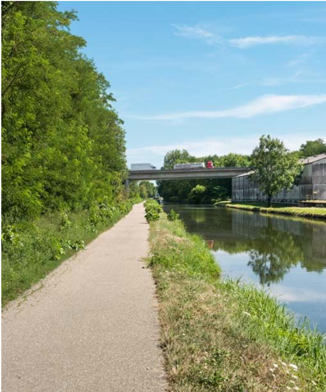
Vue d'ensemble du pont.
