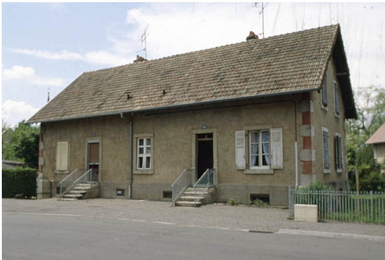
Maison à deux logements rue Kléber.
