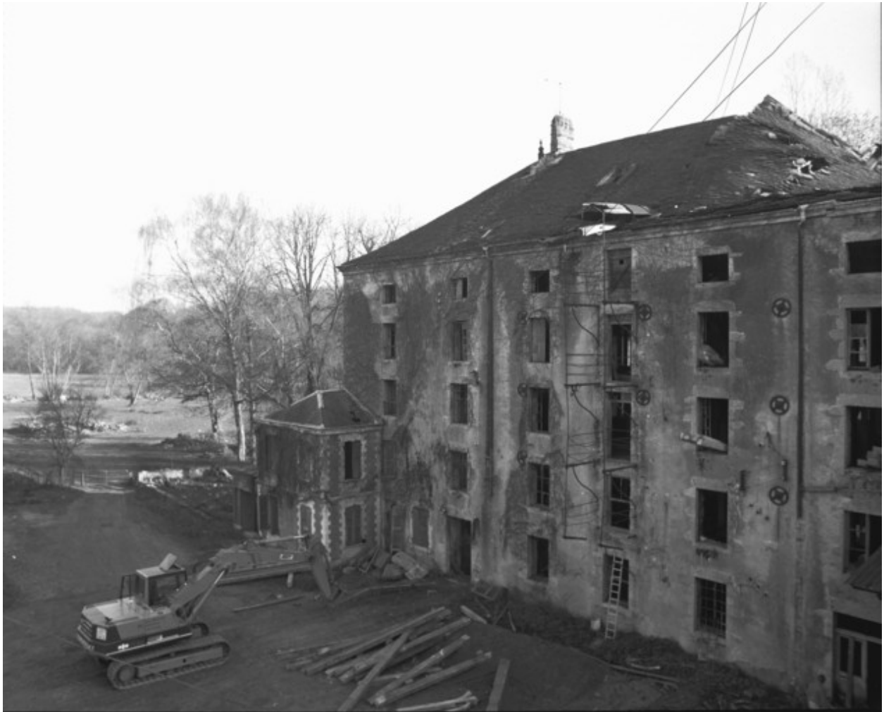
Façade antérieure du moulin public en 1989.
