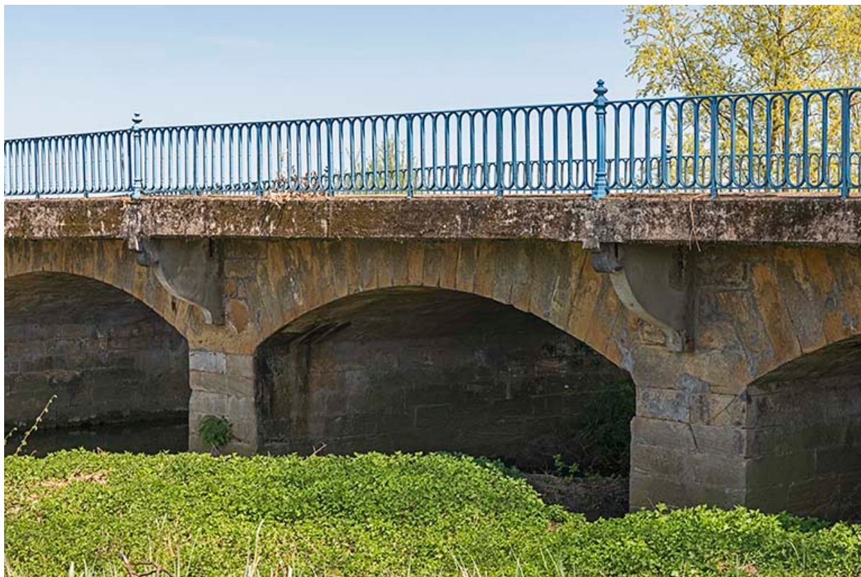
Les arches du pont, depuis l'ouest.
