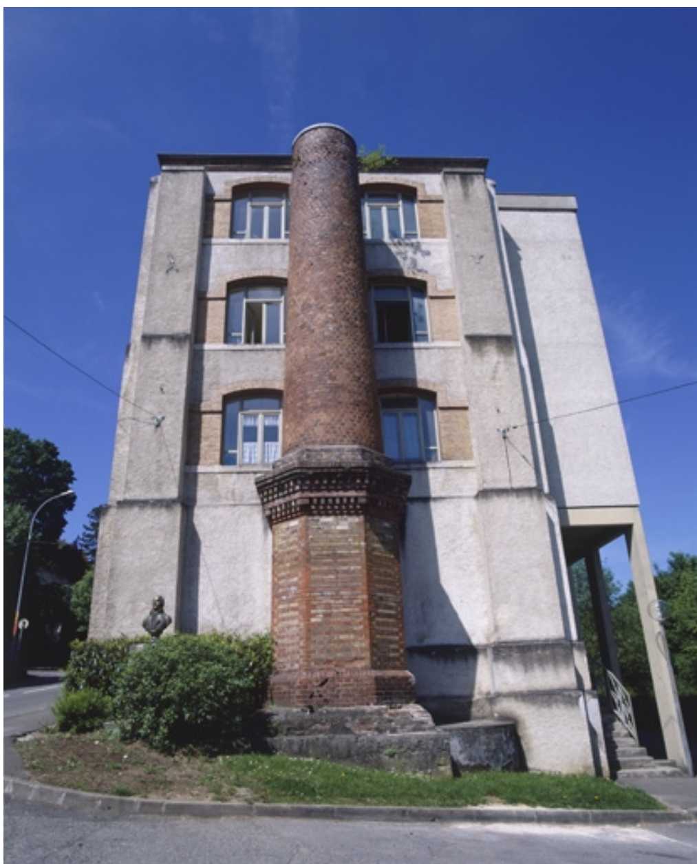
Façade est et cheminée (tronquée).
