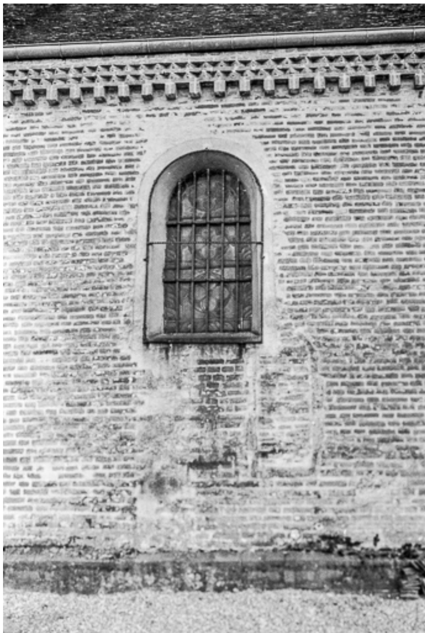
Extérieur : baie latérale.
