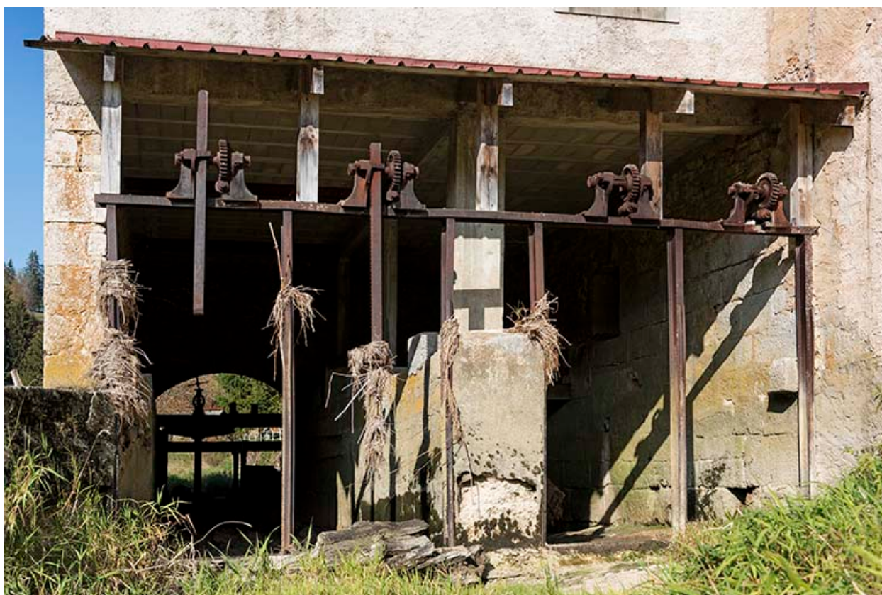
Moulin : vestiges des vannes de prise d'eau.
