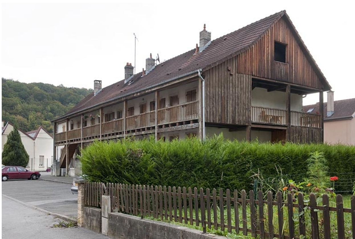
Vue de trois quarts depuis l'ouest.
