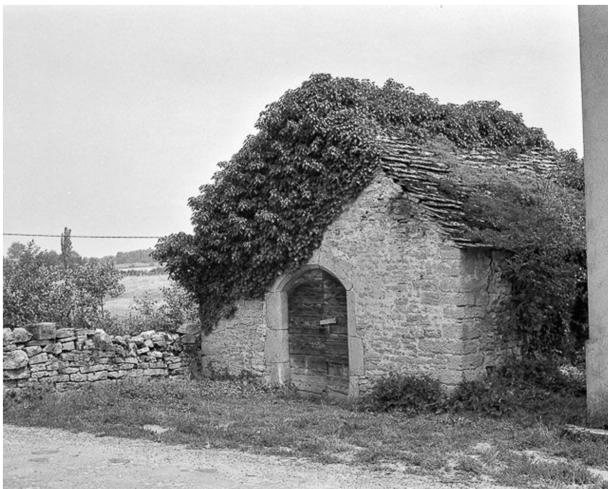
Chapelle située au lieudit Beyne.
