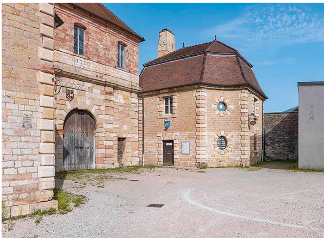
L'entrée cochère et un des pavillons.
