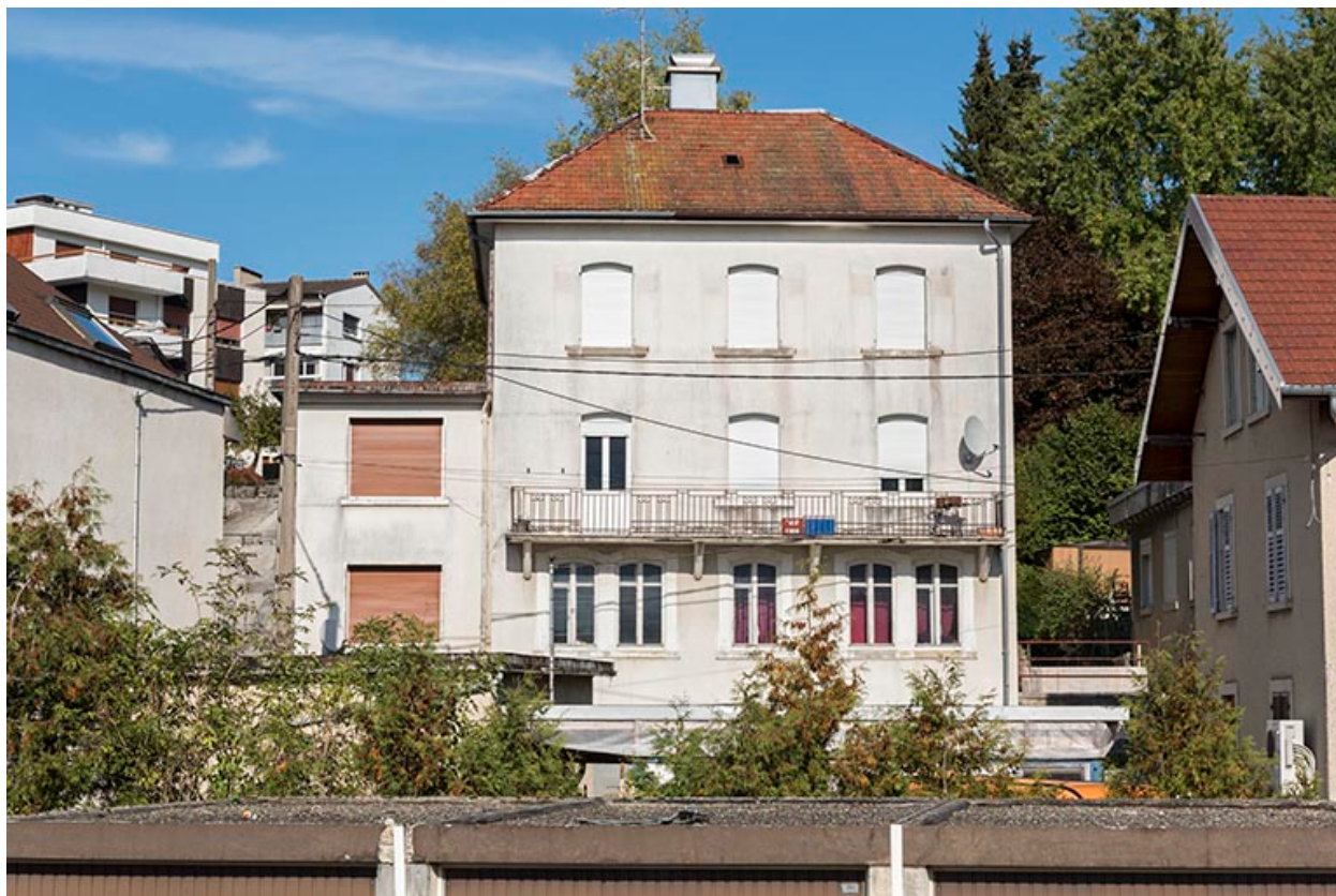
Maison : façade antérieure.
