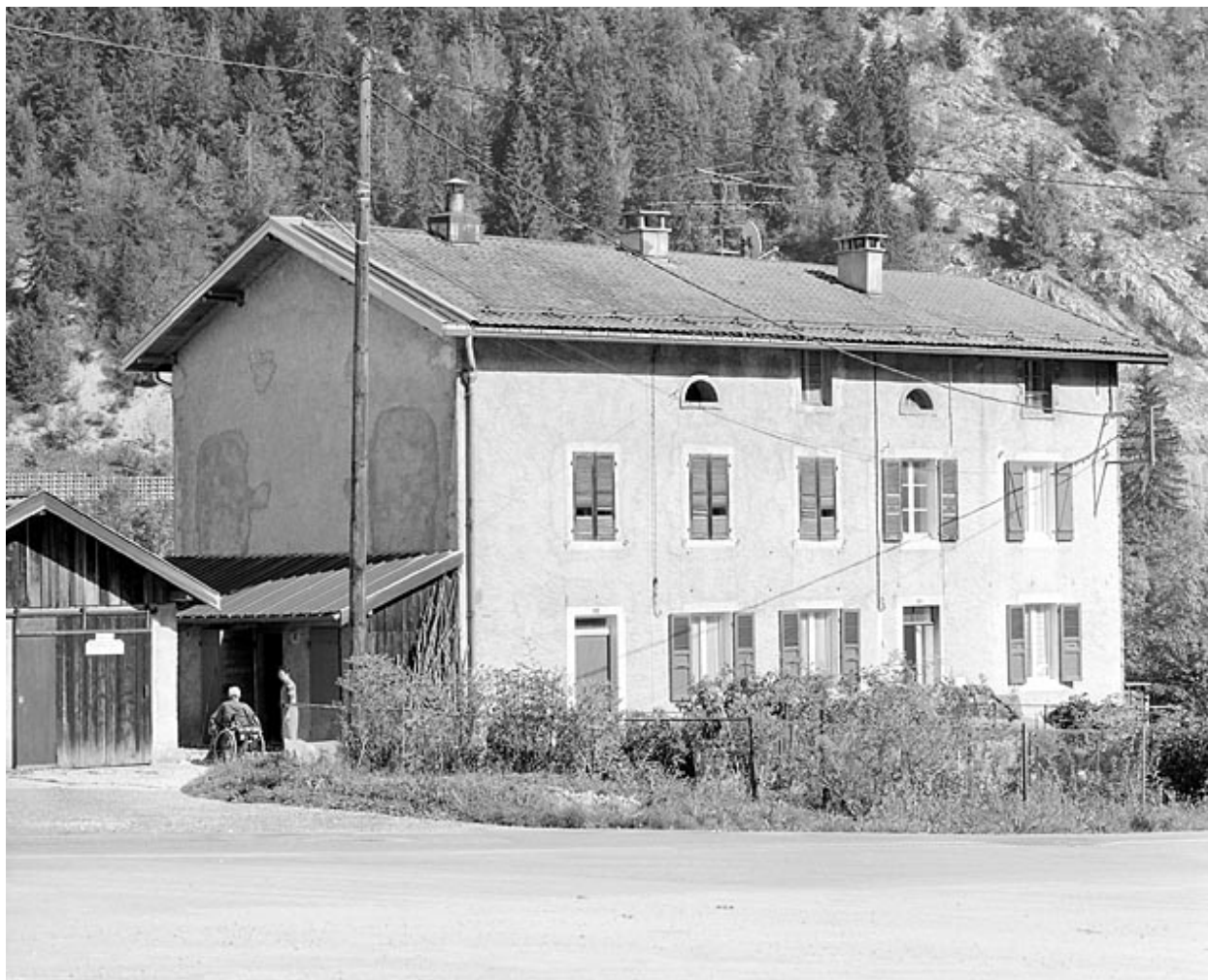
Façades antérieure et latérale gauche.
