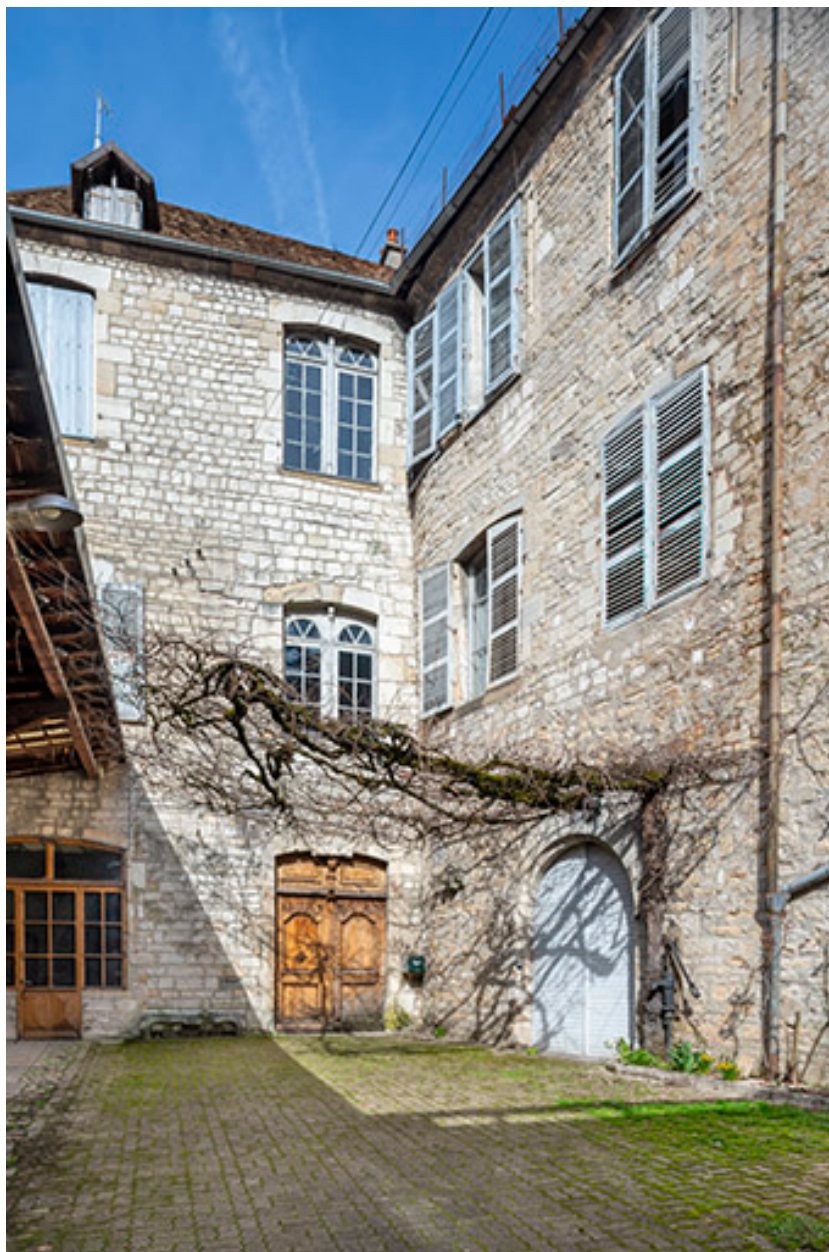
Façades est et sud depuis la cour.
