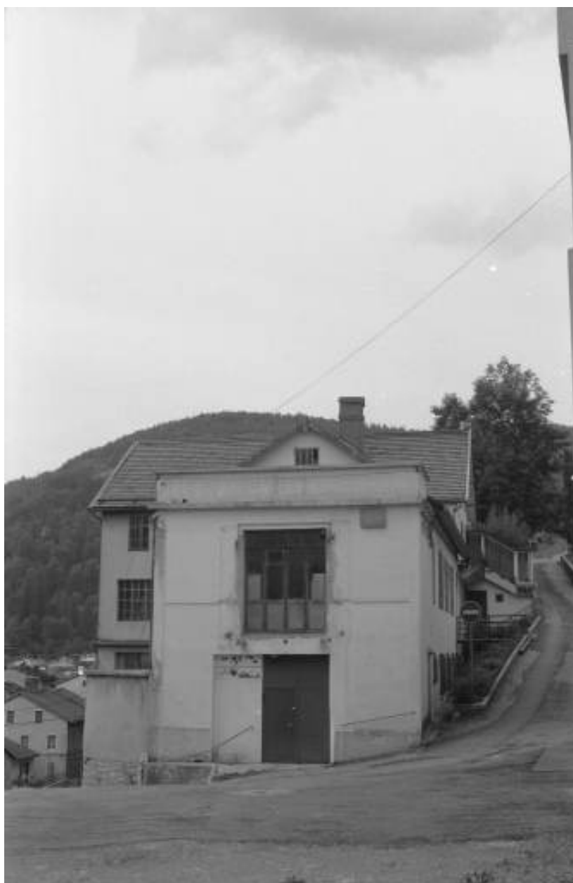
Façade latérale gauche.
