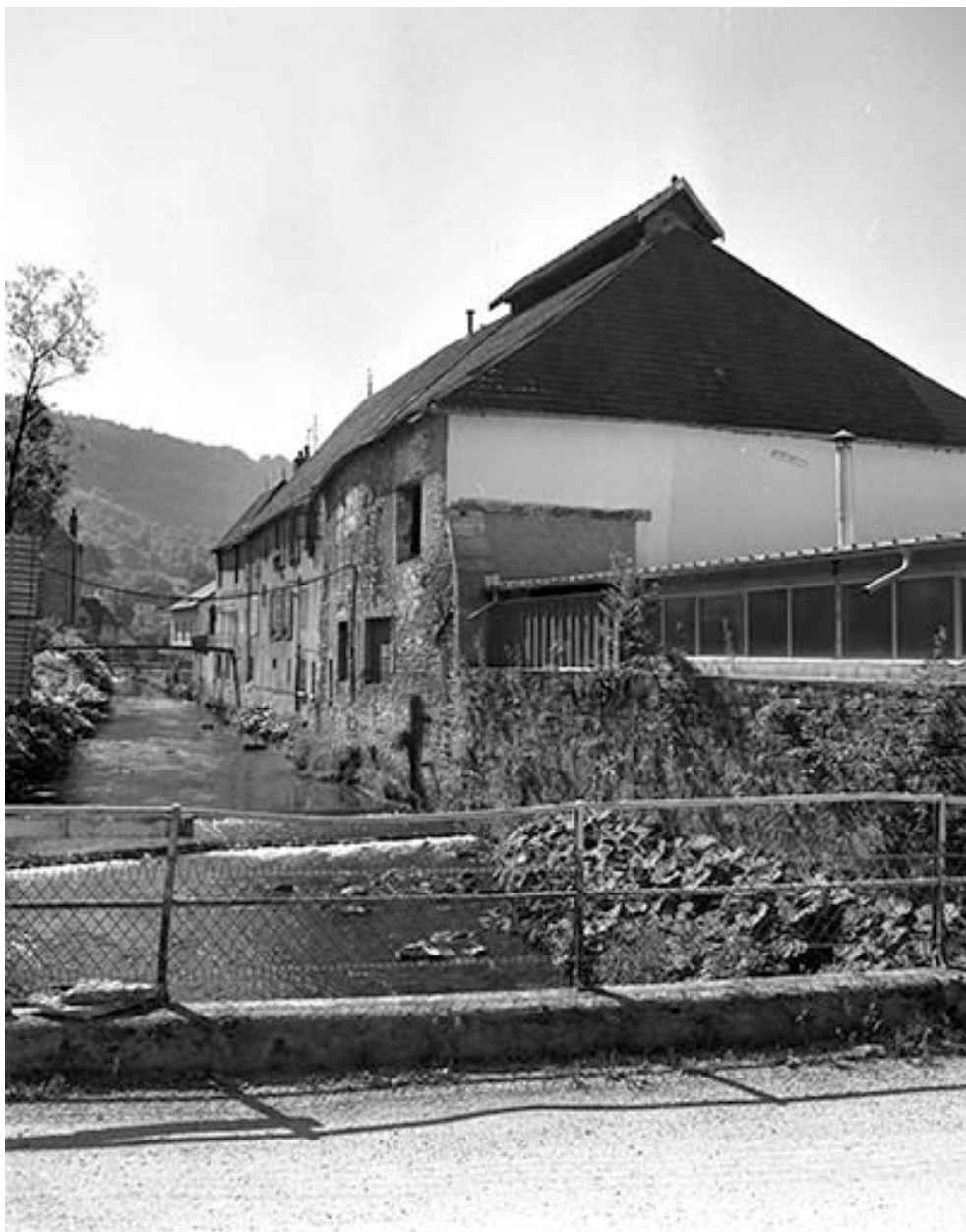
Façade postérieure de l'atelier de fabrication.
