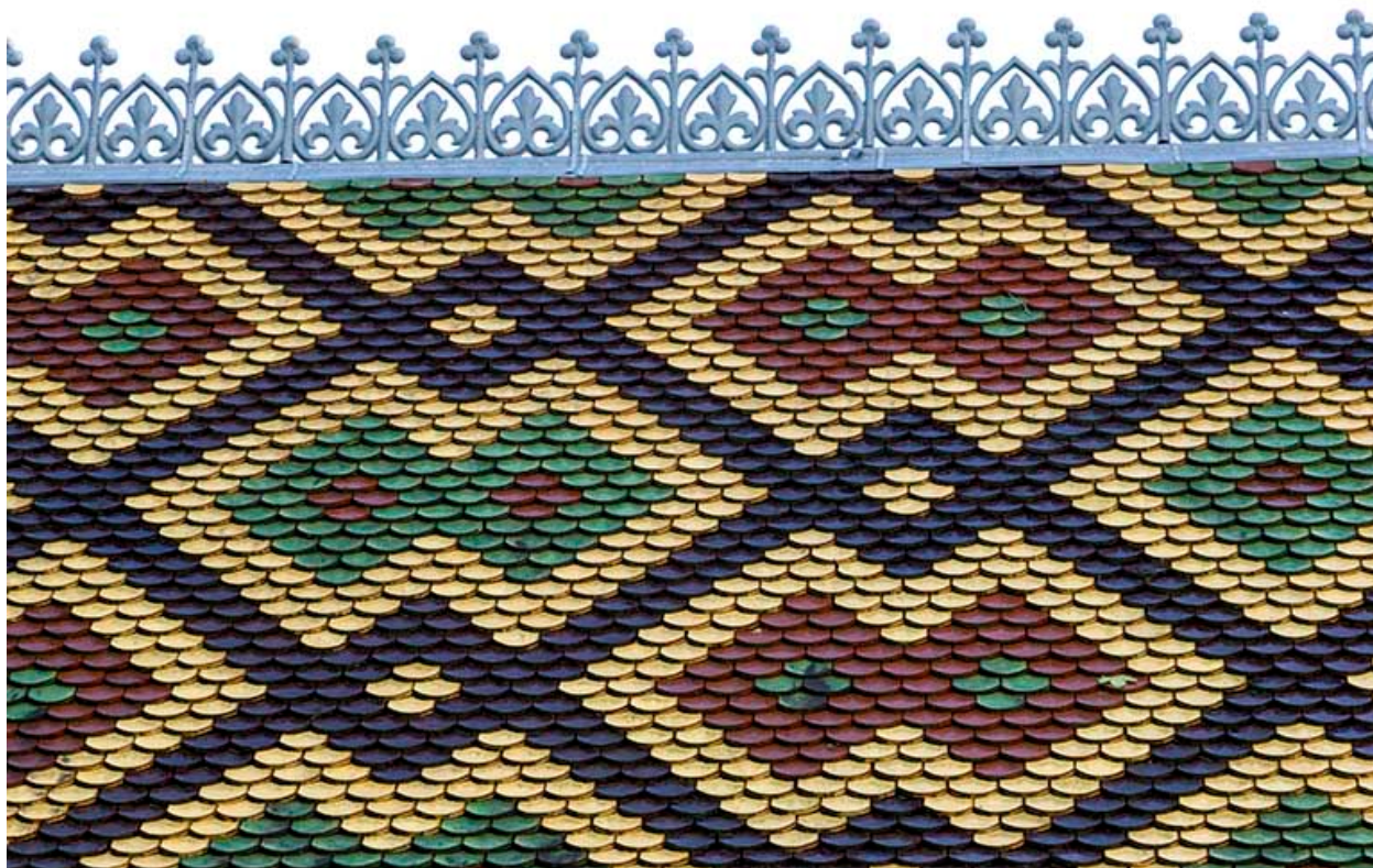
Détail : crête de toit.
