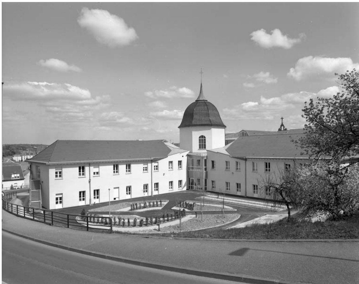
Cour à l'arrière de l'édifice : vue éloignée.
