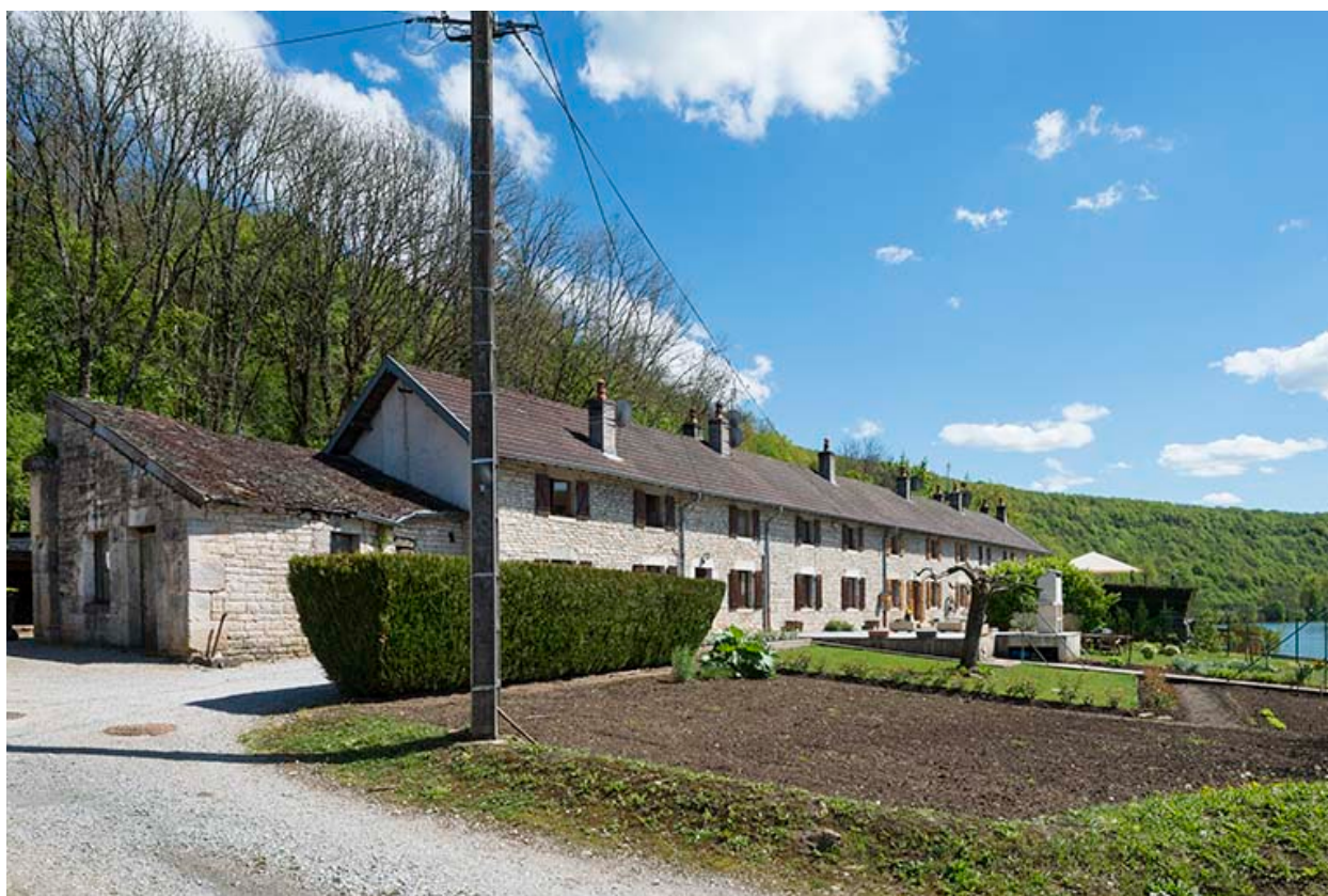
Logement ouvrier sud. Vue de trois quarts.
