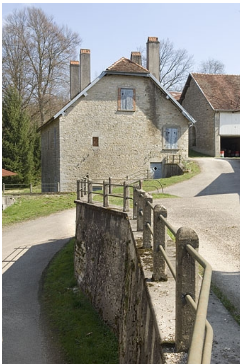
Logement ouvrier depuis la passerelle.
