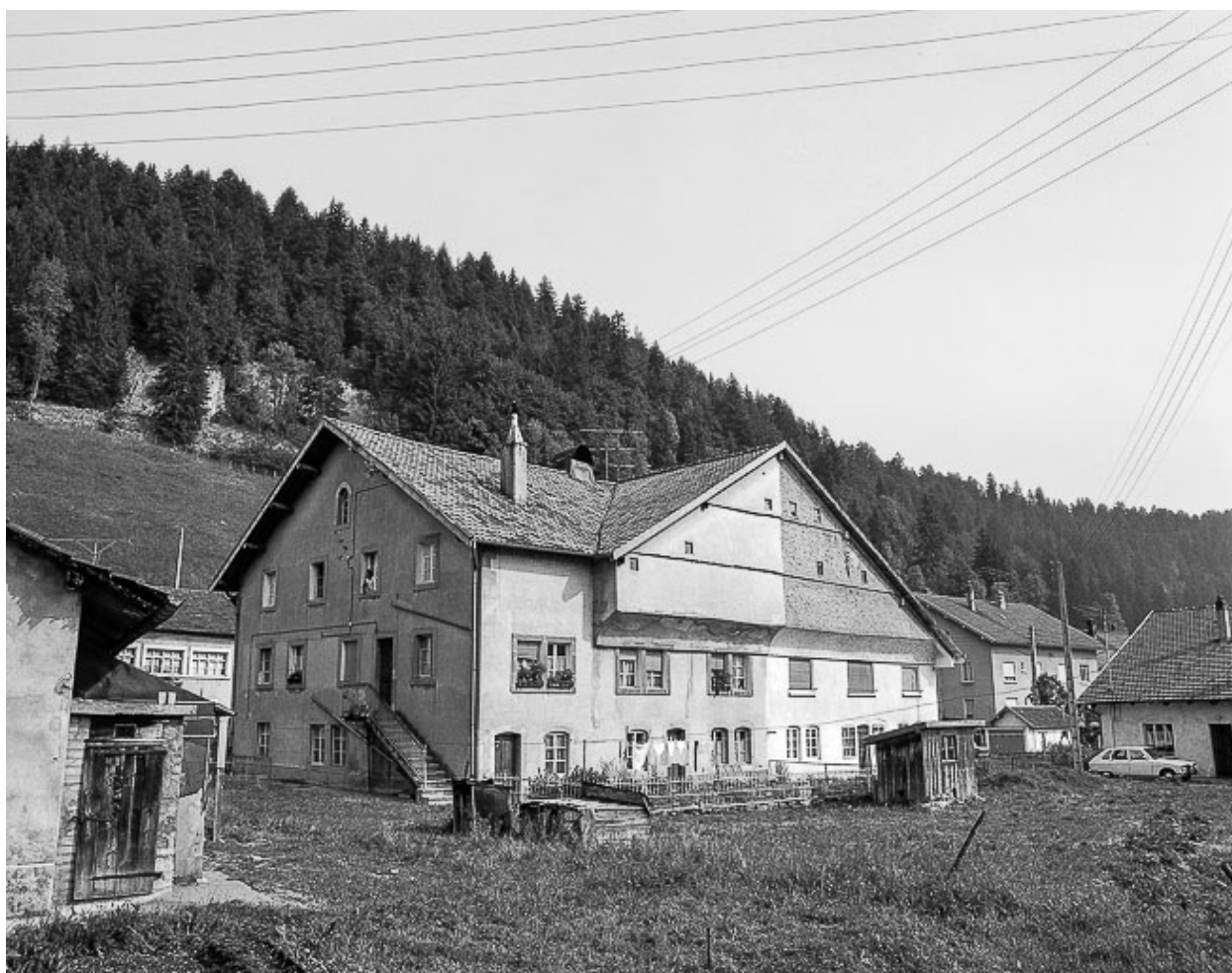
Façades postérieure et latérale droite, en 1976.
