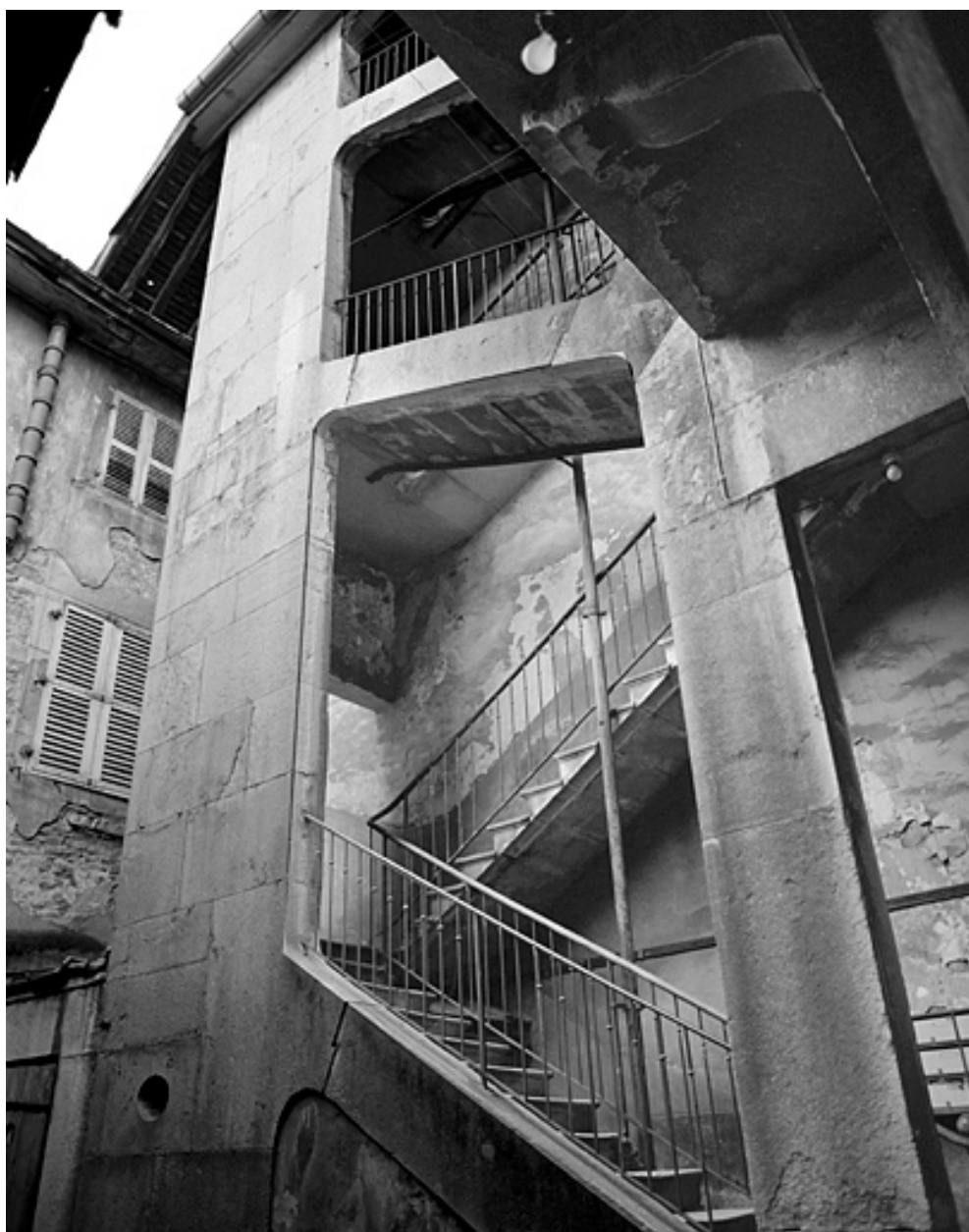
Maison, 16 rue Regard, escalier sur cour.
