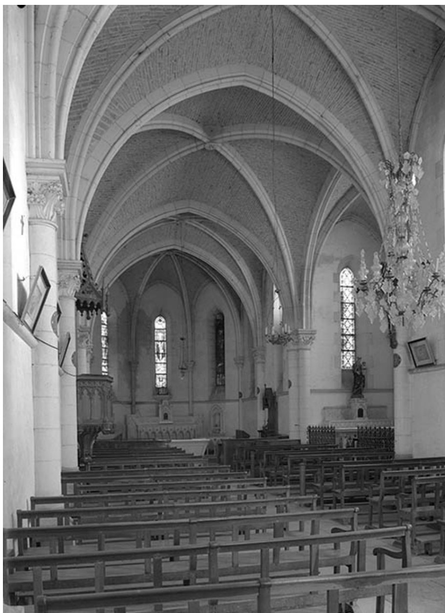
Vue intérieure vers le chœur. Voûte d'ogives.
