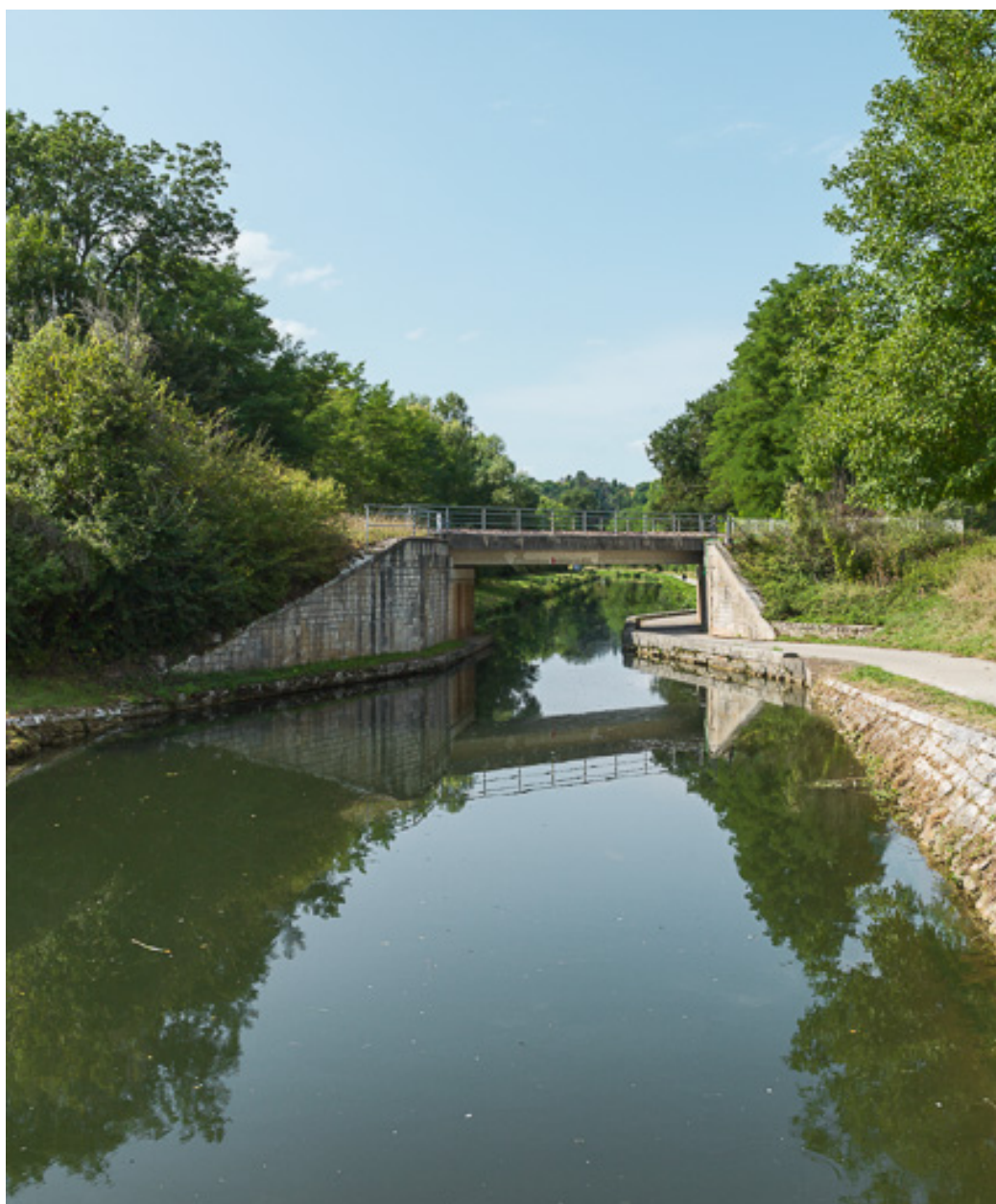
Vue d'ensemble du pont.
