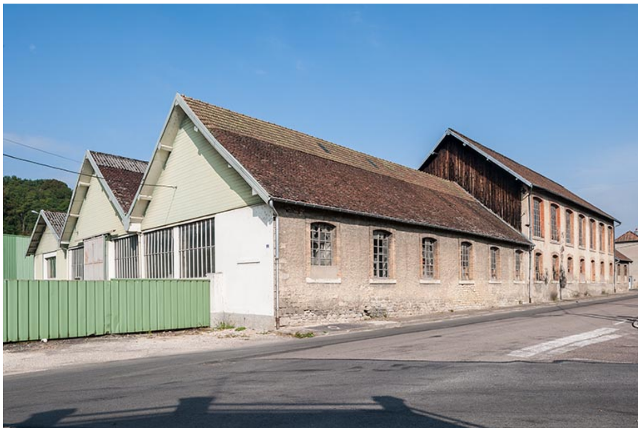
Atelier de fabrication depuis le sud-est.
