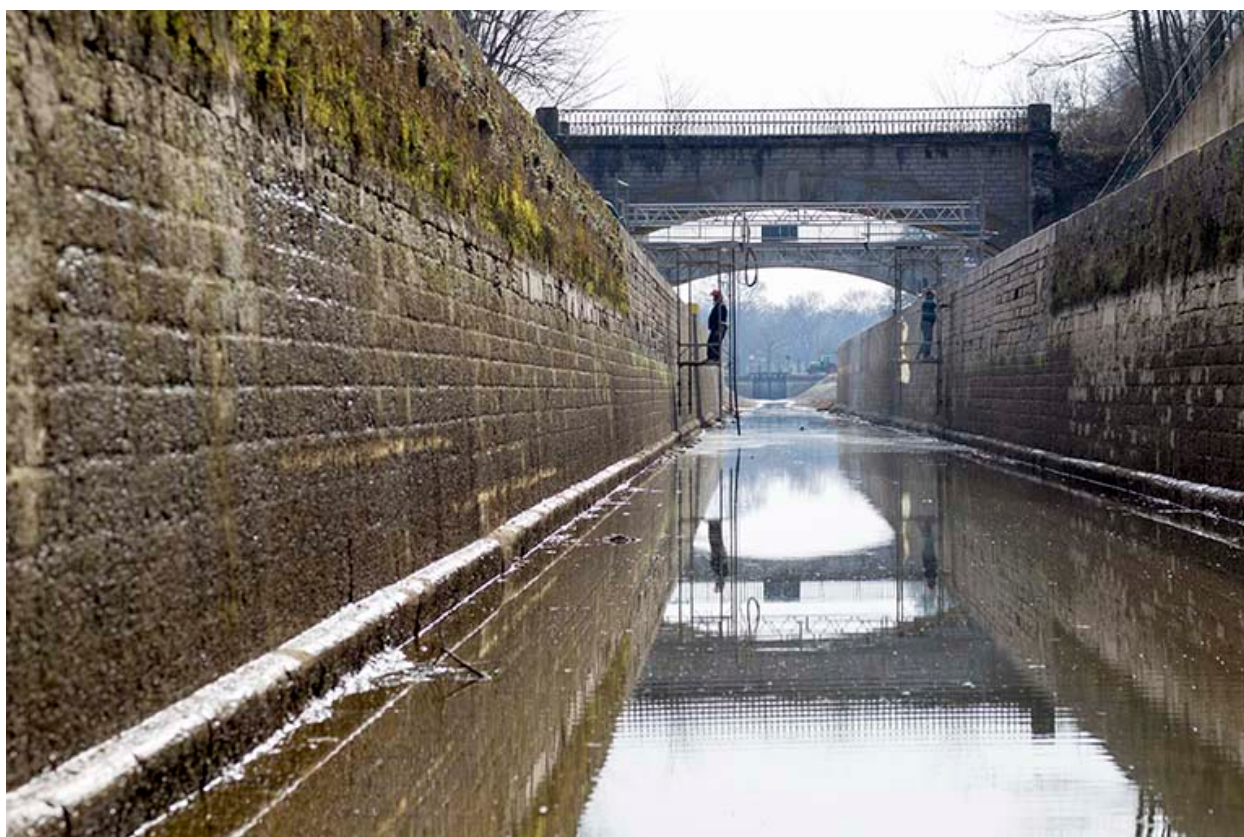
Travaux de restauration de maçonnerie en 2015.
