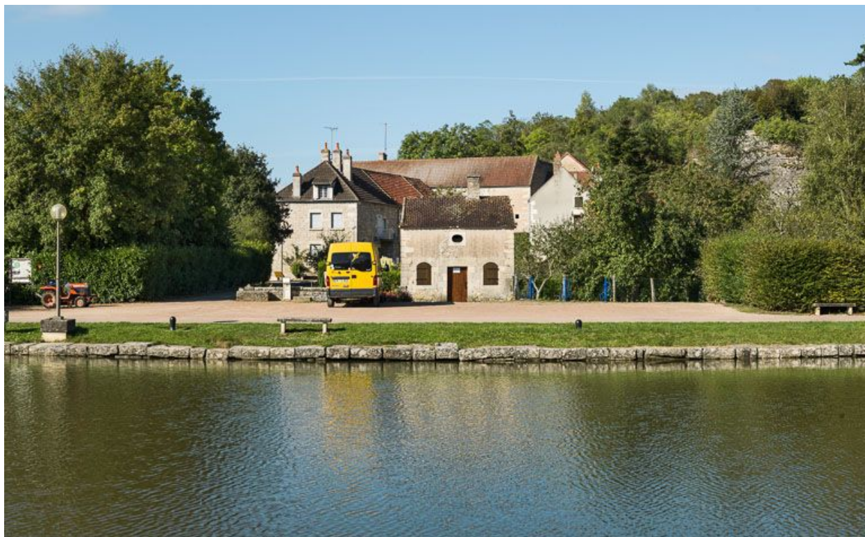
L'abri des ouvriers : vue de face.
