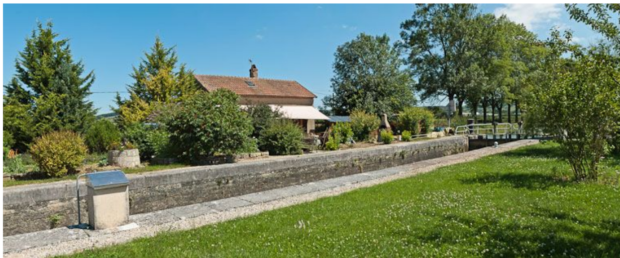
Vue d'ensemble du site d'écluse.
