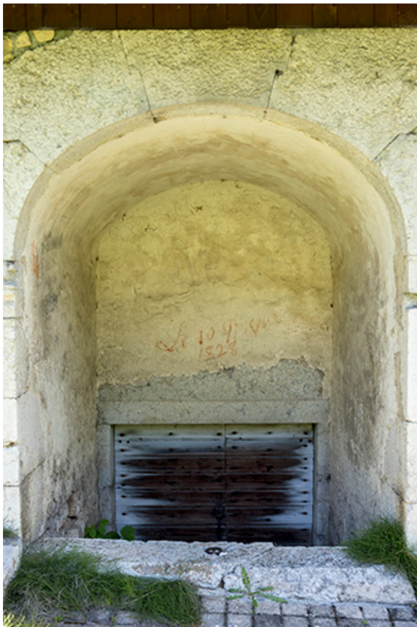
Façade sud : descente de cave et inscriptions.
