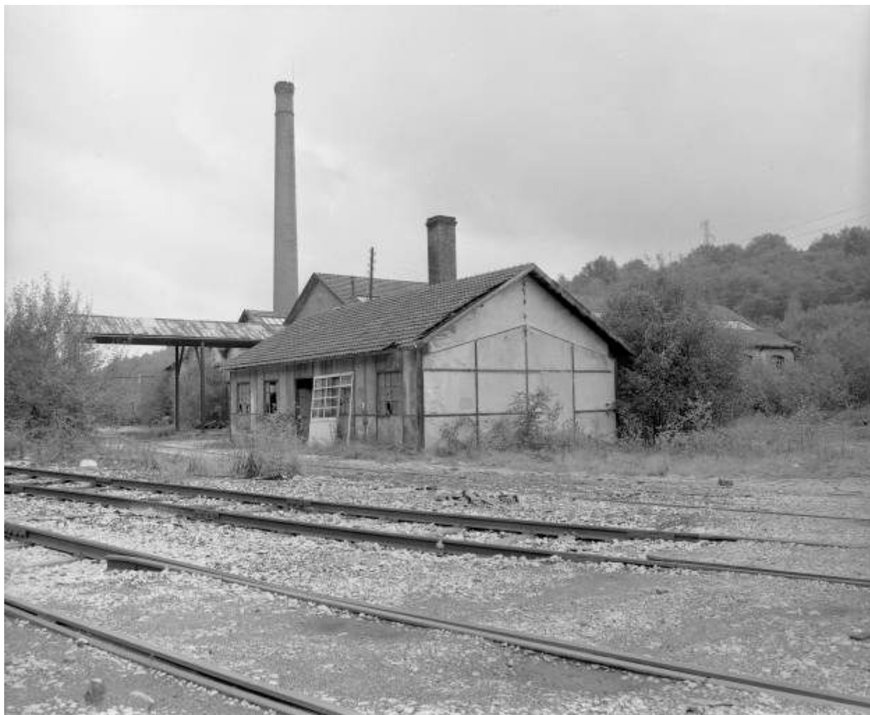
Chaudière devant l'atelier de galvanisation en 1981.
