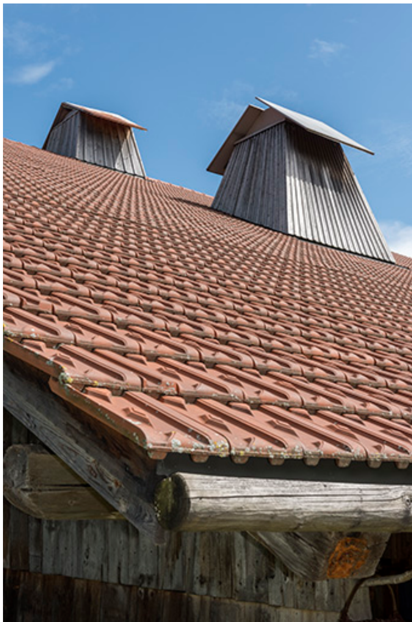
Pan de toiture sud, avec deux "tués".
