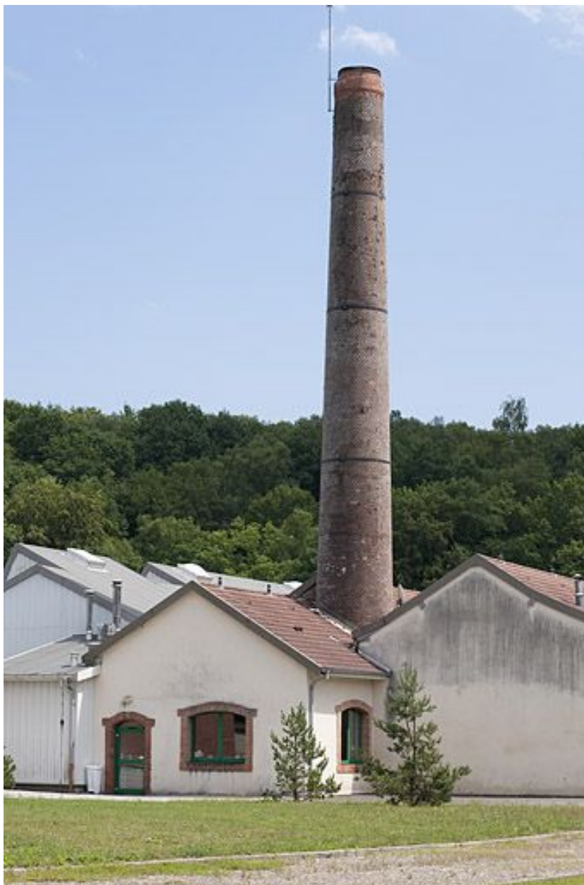
Cheminée et pignons nord des ateliers.
