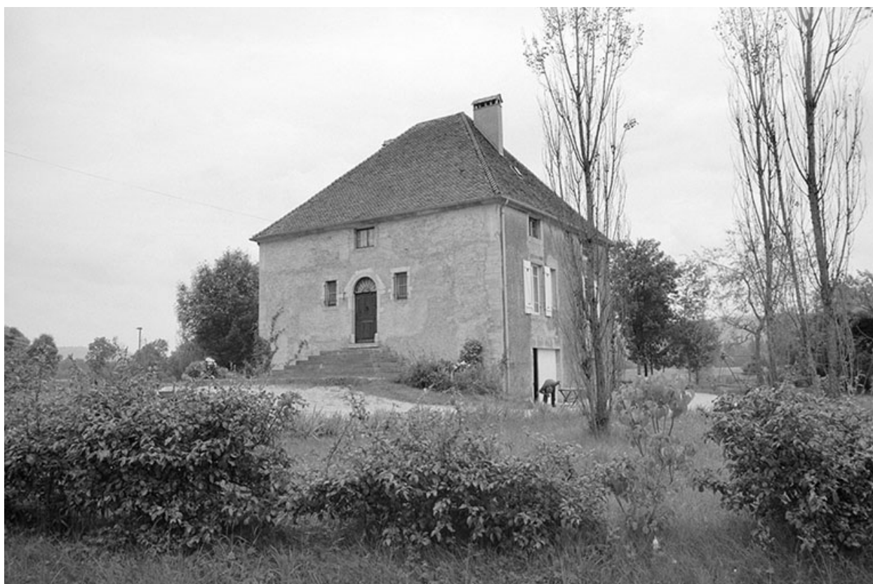
Logement d'ouvriers et bureau.
