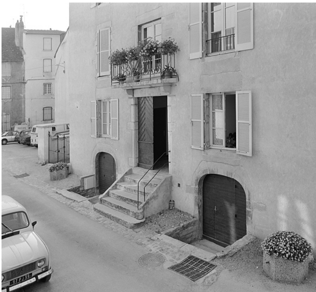
Façade antérieure, le rez-de-chaussée.
