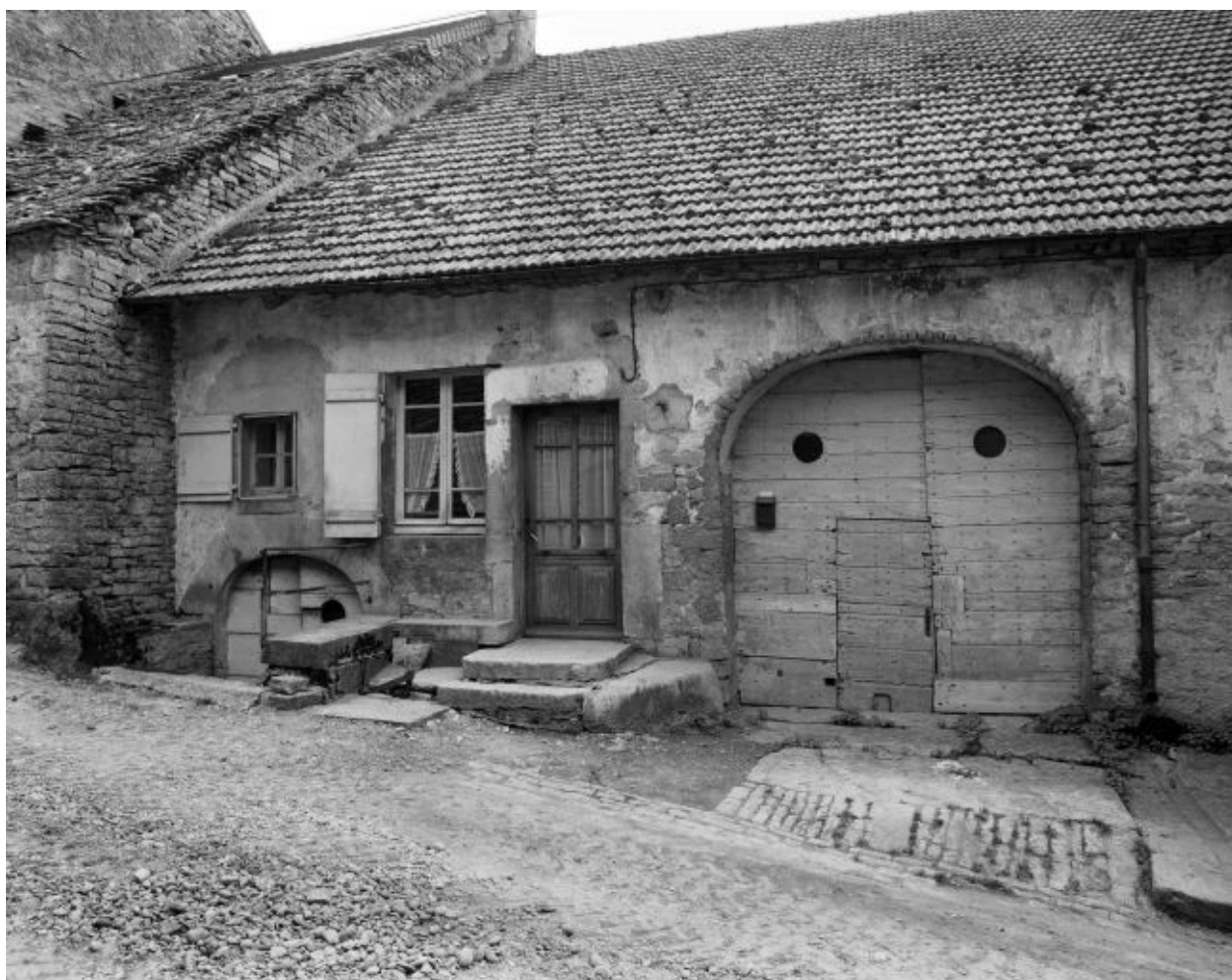
Ferme située rue des Chèvres.
