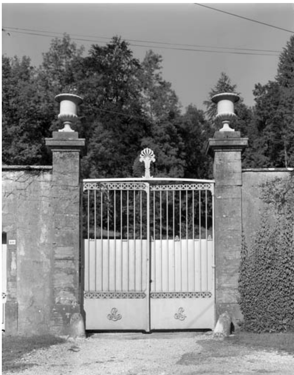
Porte d'entrée du parc.
