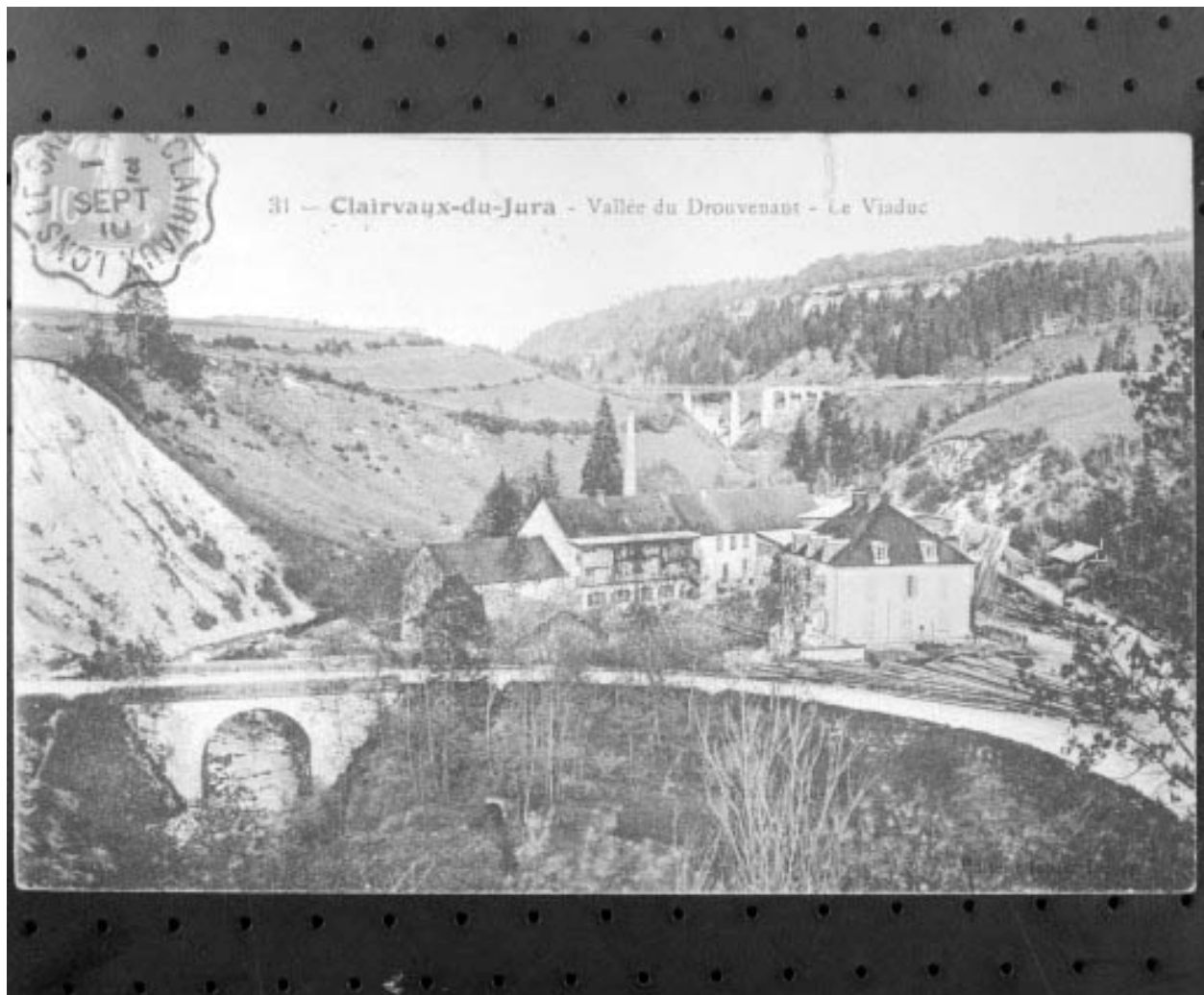
Clairvaux-du-Jura - Vallée du Drouvenant - Le Viaduc.
