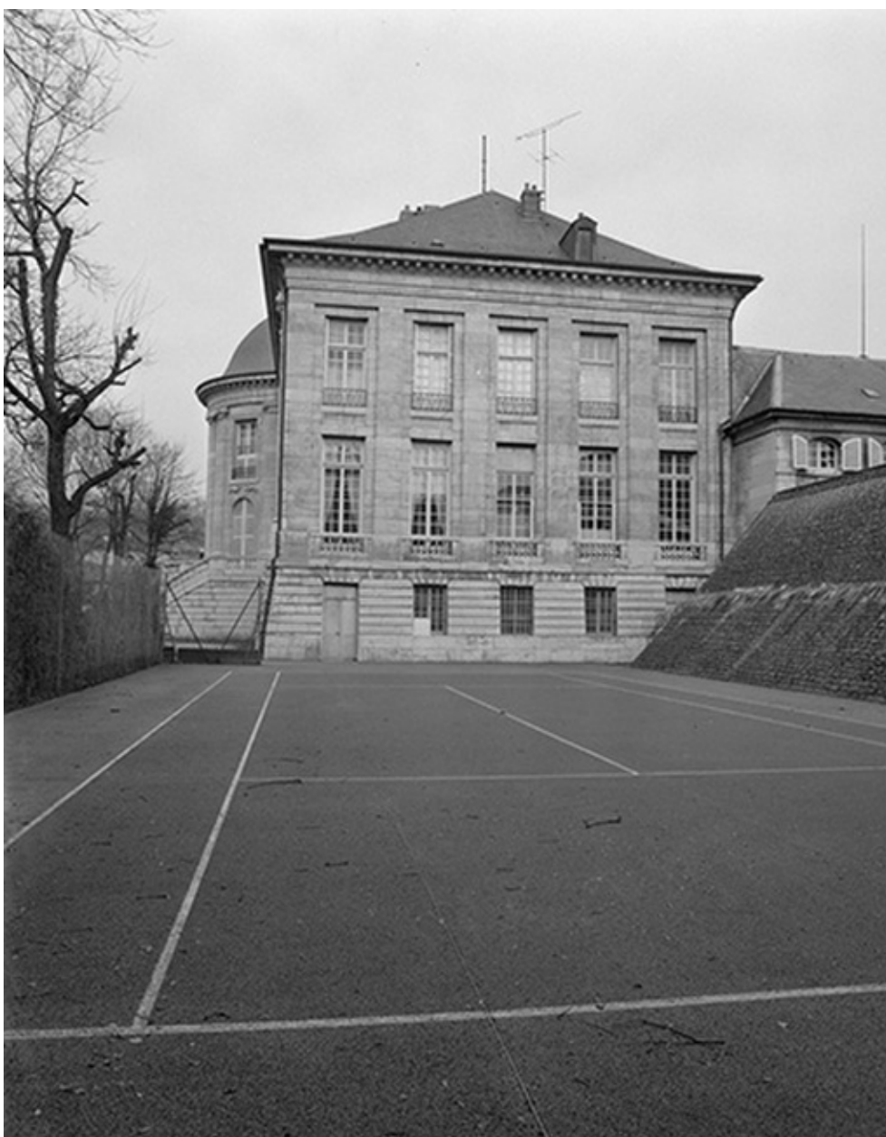
Façade latérale gauche : de face.
