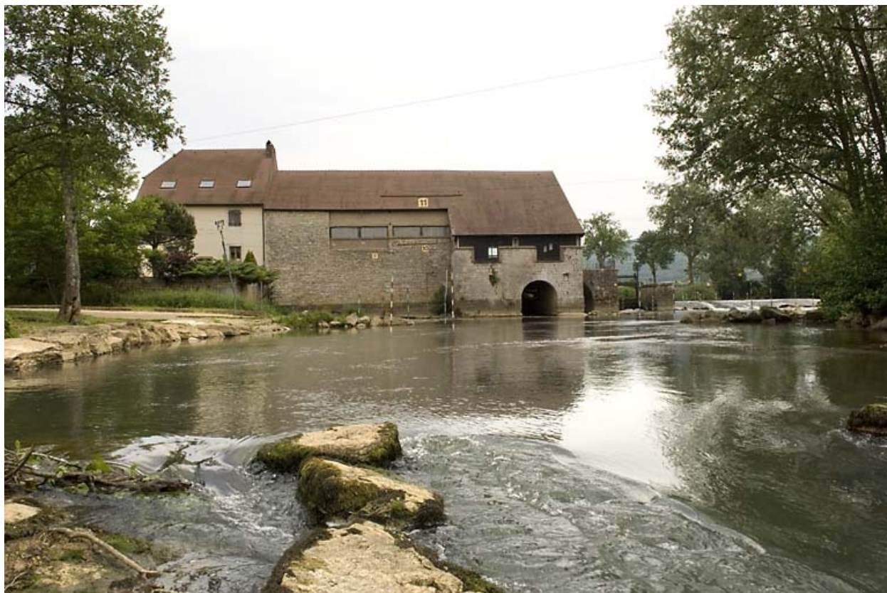
Vue d'ensemble depuis l'Ognon, en aval.
