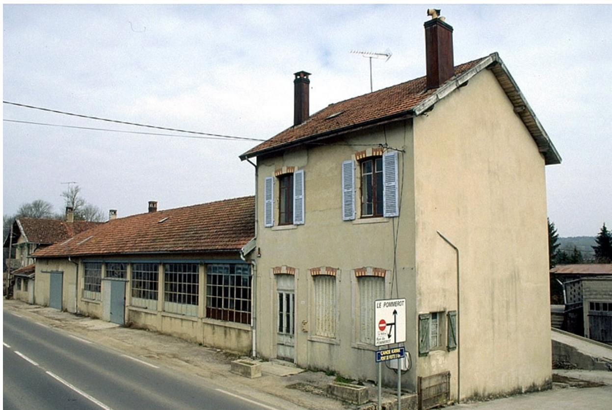
Atelier de fabrication (tabletterie) et logement.
