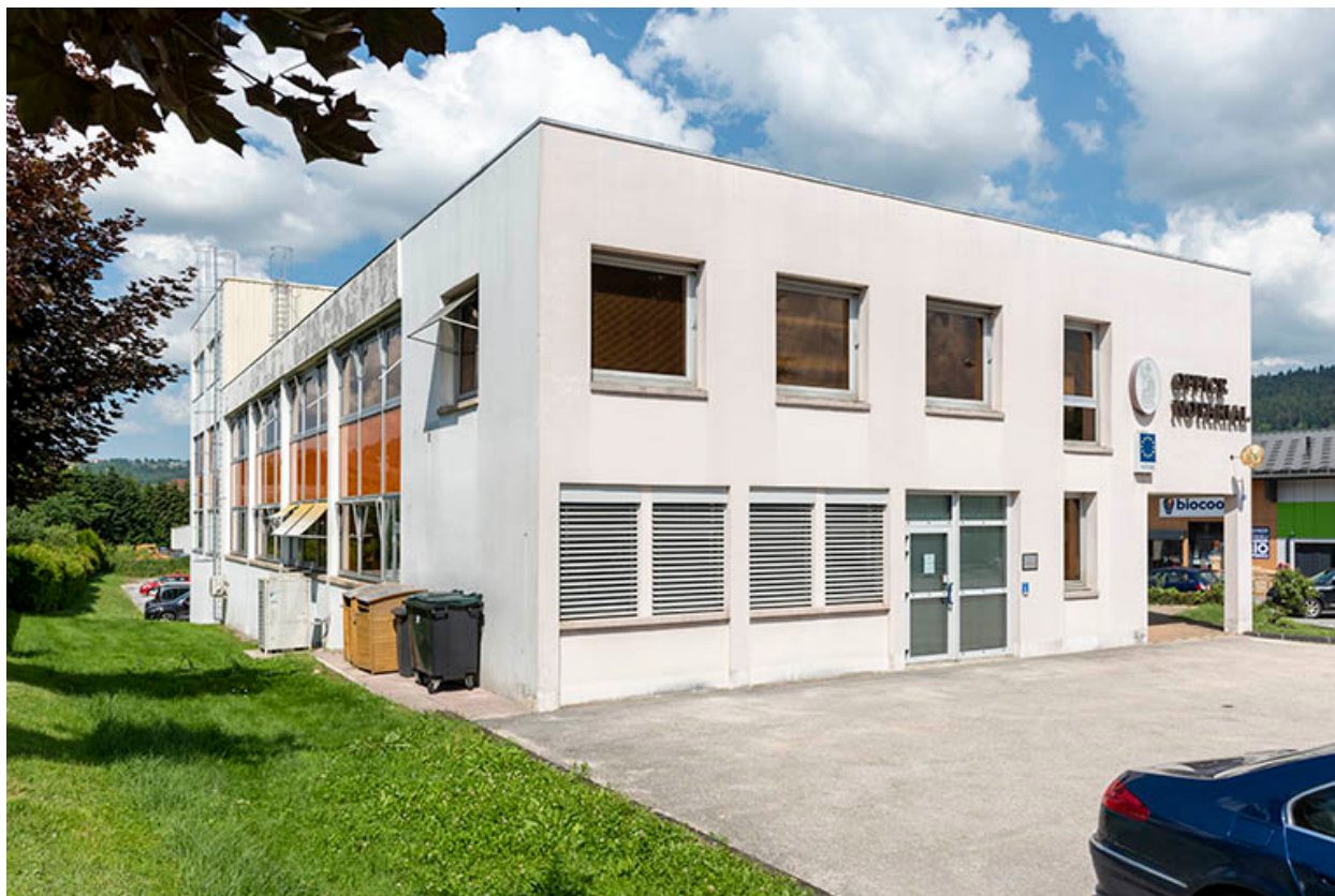
Façade sud, de trois quarts gauche.
