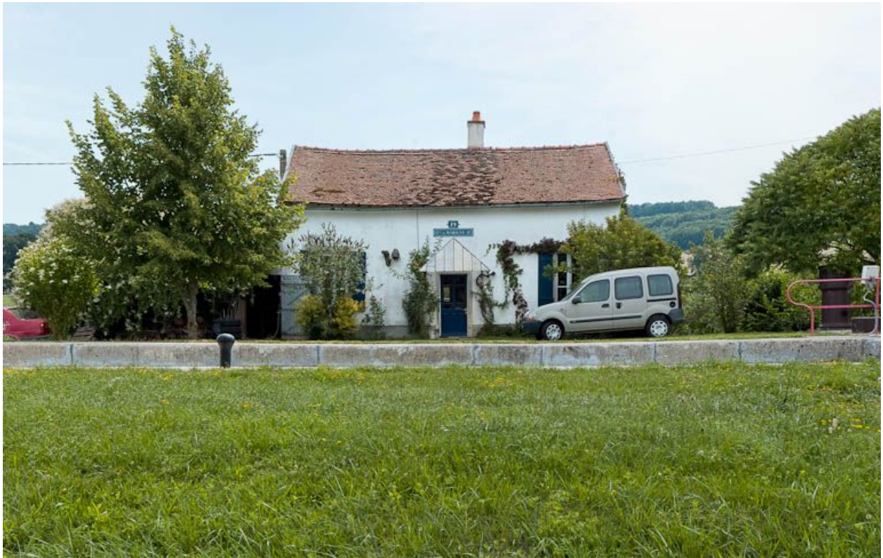
Vue de face de la maison éclusière.
