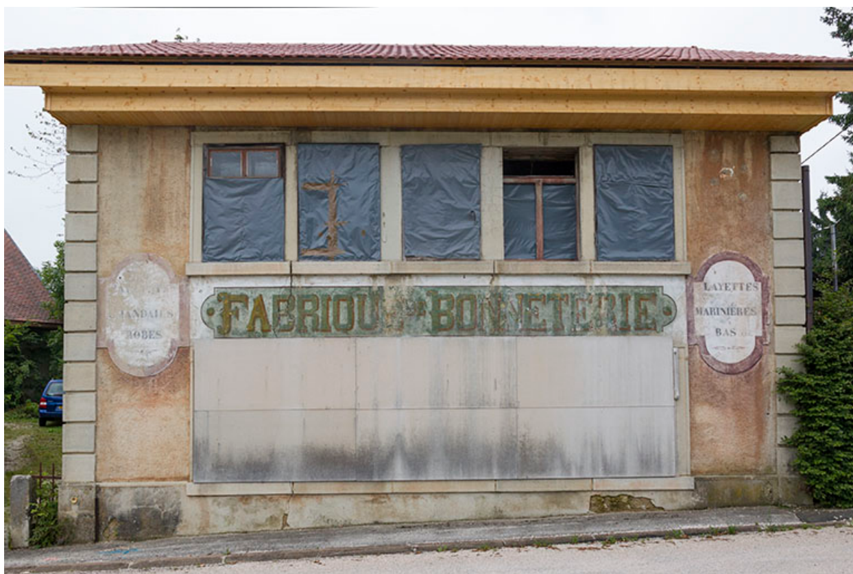
Usine : façade antérieure.
